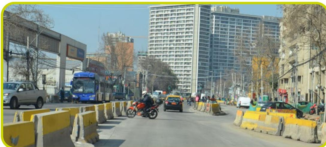
*Fotografía 3 – Muestra maniobra arriesgada de moto por no estar conectados los segmentos de barrera de hormigón.*
