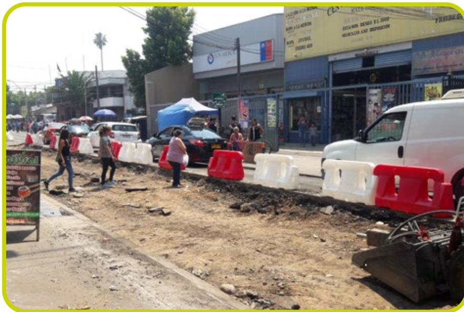
*Fotografía 2 – Muestra movimiento peatonal de riesgo por no estar conectados los segmentos de barreras articuladas.*
